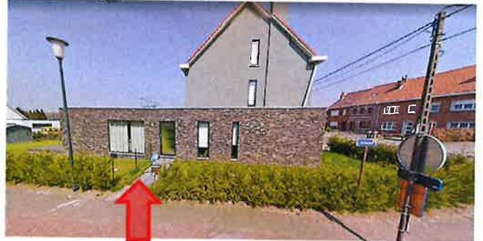
ingang langs de Berkenlaan?
